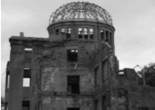
写真⑤ ノーヒント。この建物の名
