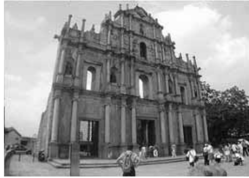
写真② 正面の壁のみが残っている 天主堂の名
